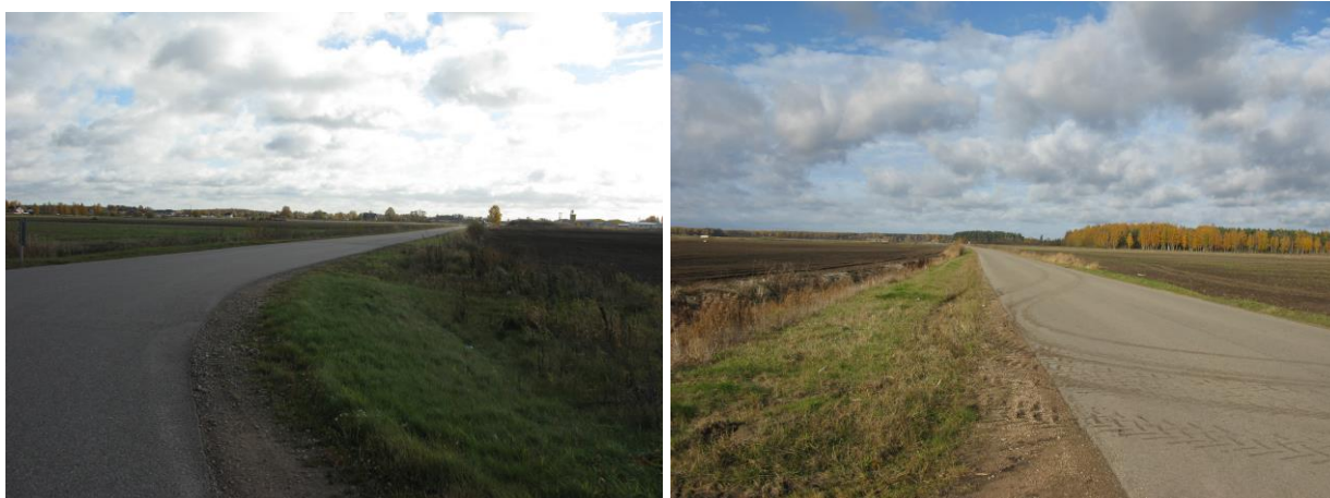
15.,16.attēls. Skats uz pašvaldības ceļu Tīreļi – atkritumu izgāztuve.
